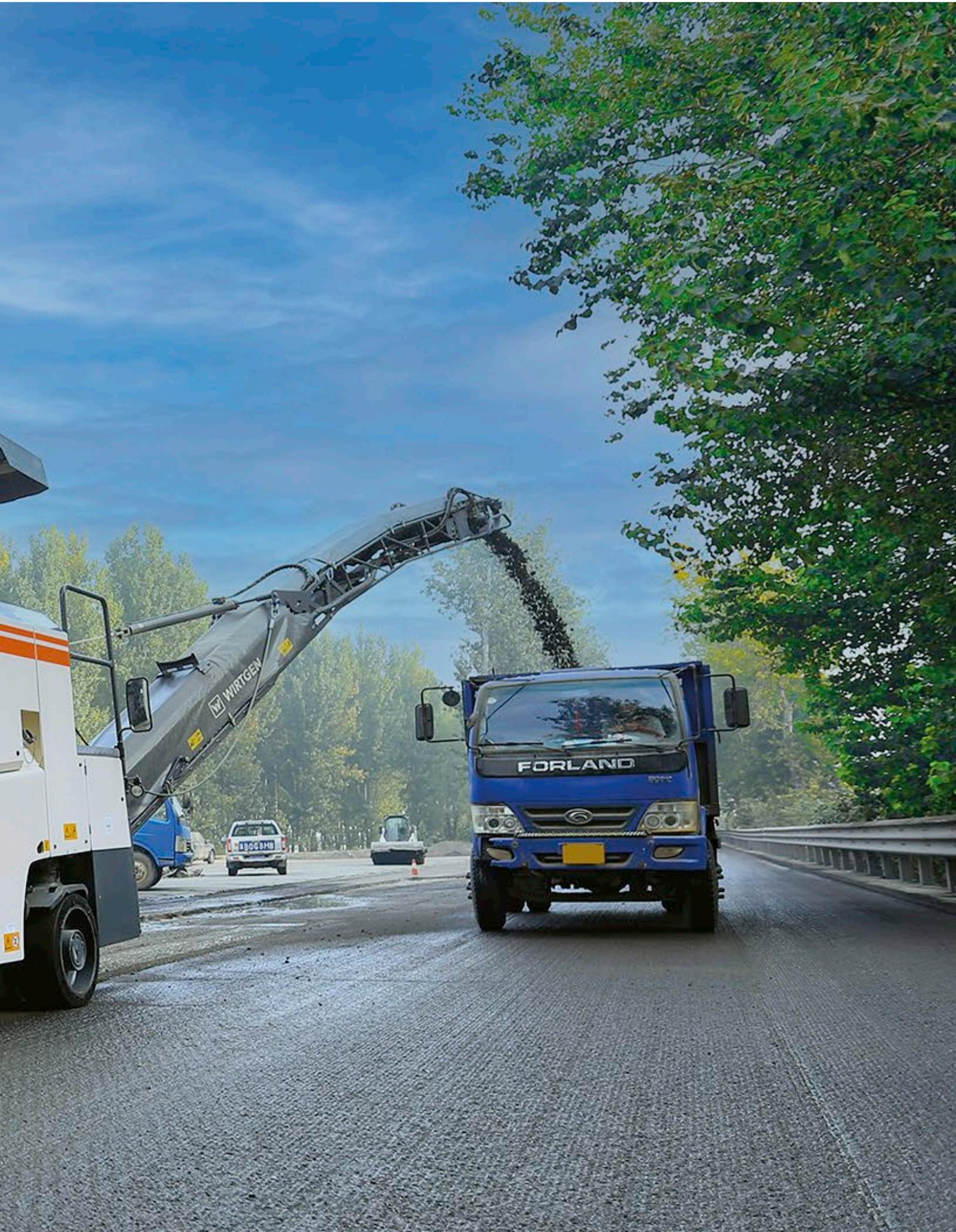
La fresadora en frío de alto rendimiento en la clase de un metro está diseñada para operaciones de fresado rentables a anchuras de trabajo de 1,0 m o 1,3 m. Su sistema de carga trasera de alta capacidad transporta hasta 92 m<sup>3</sup>/h y se puede controlar fácilmente mediante el joystick multifuncional. Tres velocidades de giro del tambor de fresado seleccionables permiten un alto rendimiento de fresado independientemente de la situación de trabajo.
