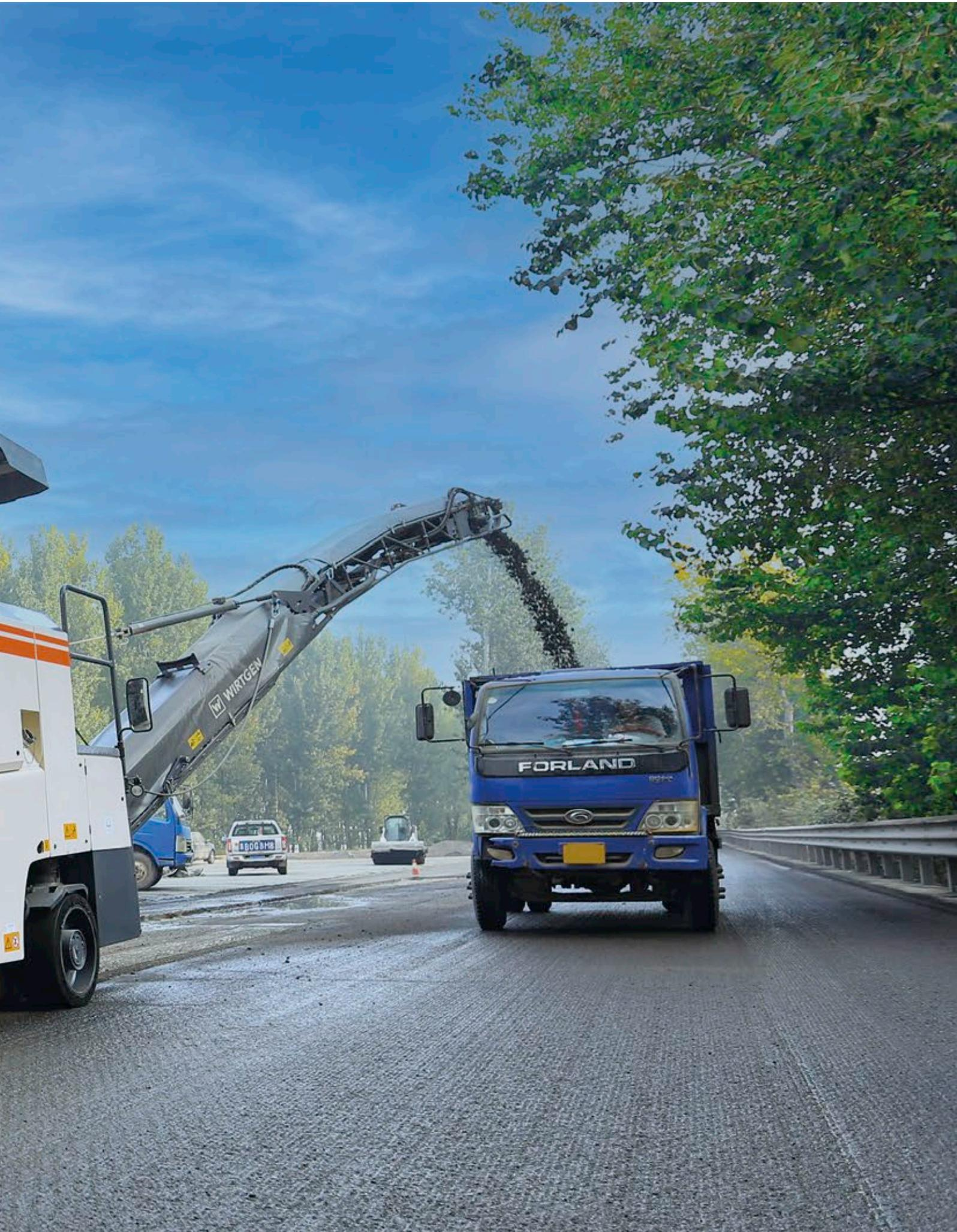
高性能一米档冷铣刨机以 1 m 或 1.3 m 两个铣刨宽度经济、高效地施工。强劲的后出料皮带每小时输送量高达 92 m<sup>3</sup>，由多功能操控手柄，轻松掌控。三档铣刨鼓转子切换功能，可根据不同工况实现理想的匹配，确保更高的铣刨性能。
