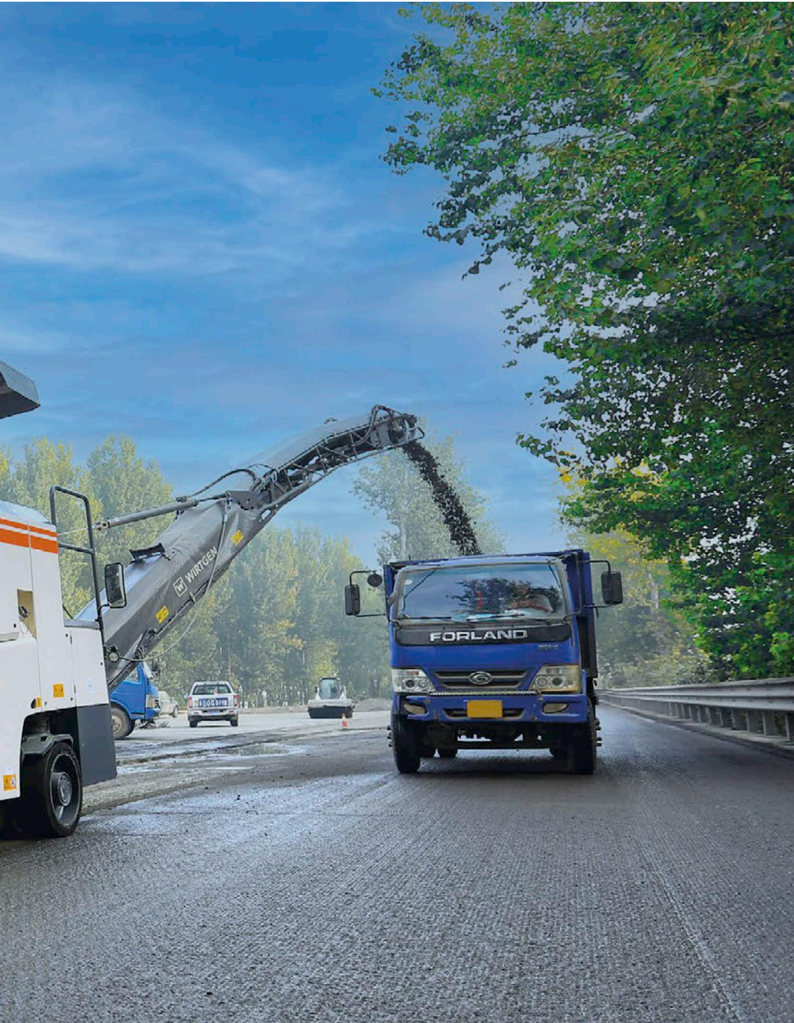
A fresadora a frio de alto desempenho da classe de 1 metro foi projetada para operações de fresagem econômicas em larguras de trabalho de 1,0 m ou 1,3 m. Seu sistema de carregamento traseiro de alta capacidade transporta até 92 m<sup>3</sup>/h e pode ser facilmente controlado pelo joystick multifuncional. As três velocidades selecionáveis do tambor de fresagem permitem um alto desempenho de fresagem independentemente da situação de trabalho.
