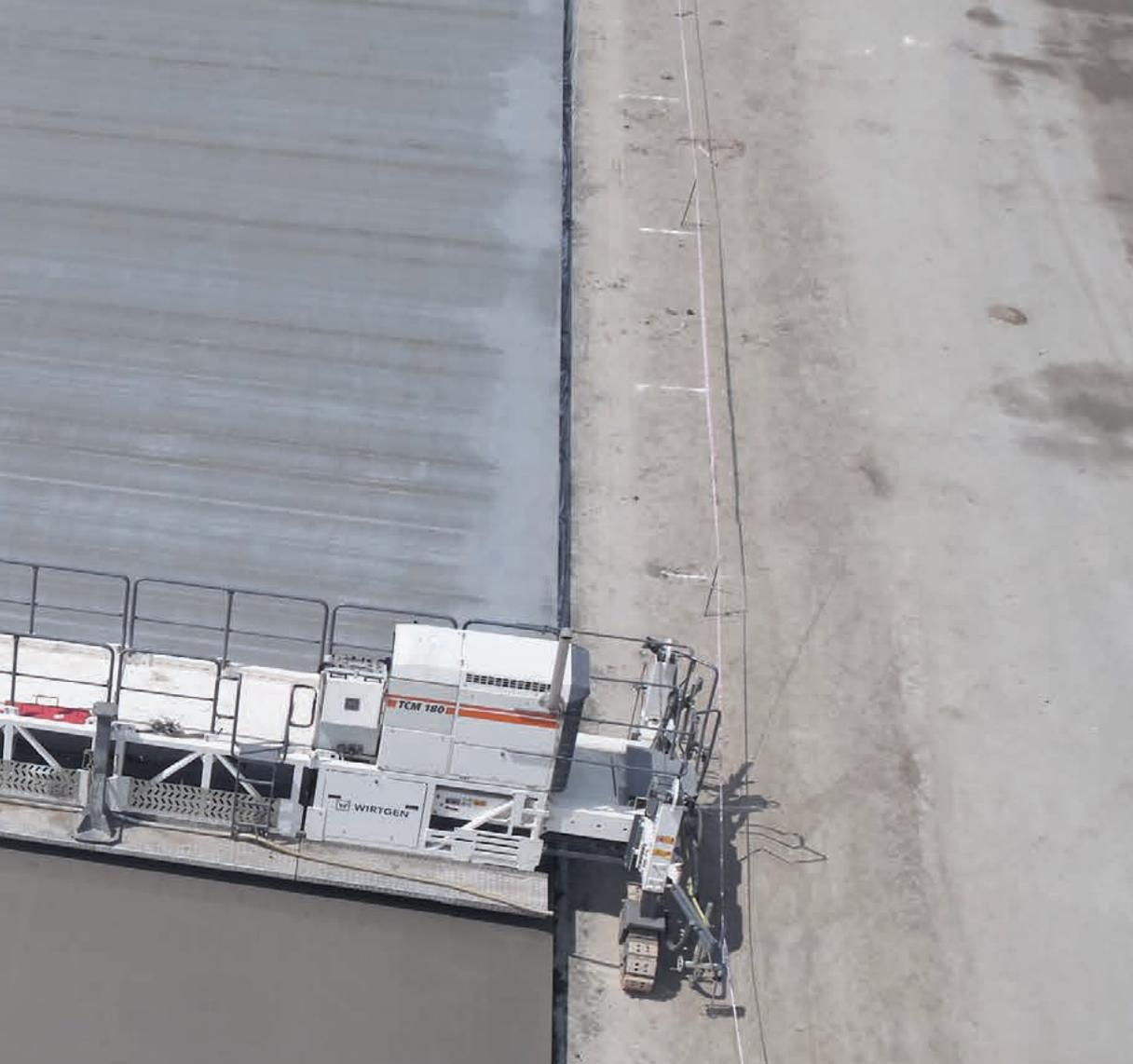
1 | Das Nachbehandlungsgesetz sorgt für die geforderte Oberflächenstruktur und bringt im gleichen Arbeitsgang eine Kombidispergierung zum Schutz der Oberfläche auf.
