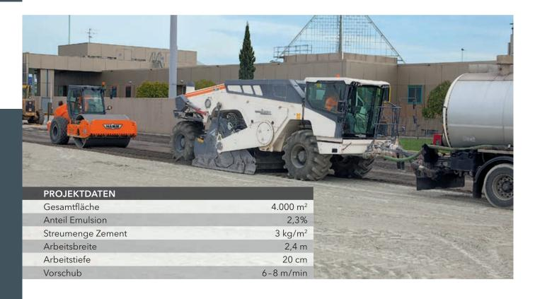
Im vorderen Bereich des Walzengehäuses düst der WR 250 über Einsprühleisten Emulsion und Wasser in den Mischraum ein. Im Rahmen der Sanierungsarbeiten auf der Autobahn A4 bei Verona (Italien) werden Tragfähigkeitsdefizite der Zufahrt zu einer Mautstation behoben. Zu diesem Zweck rückt ein schlagkräftiger Recyclingzug an – formiert aus einem Wassertankwagen, einem Emulsionstankwagen, dem WR 250, dem Hamm Vibrations-Walzenzug 3520 und einem
