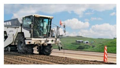
Der WR 250 pulverisiert die bestehende Fahrbahn und zusätzlich aufgebrachten Schotter bis zu 56 cm tief.
